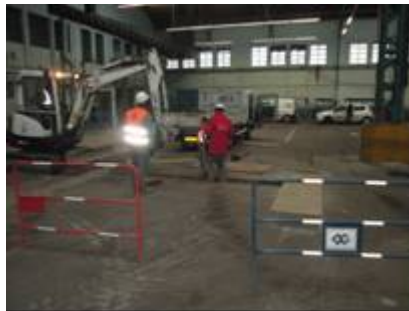
Figure 12 : Réfection de la dalle béton
