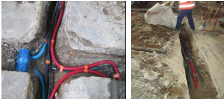
Figure 10 : Installation des réseaux de pompage et d'injection
