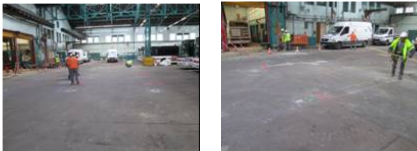
Figure 7 : Implantation et marquage au sol des tranchées et des joints amiantés
