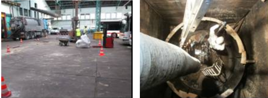
Figure 4 : Pompage et dégazage de la cuve 8m 3 par la société JB.Bonnefond
