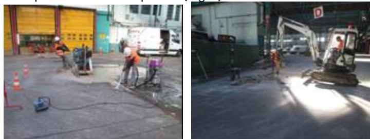
Figure 8 : Sciage et démantèlement de la dalle béton
