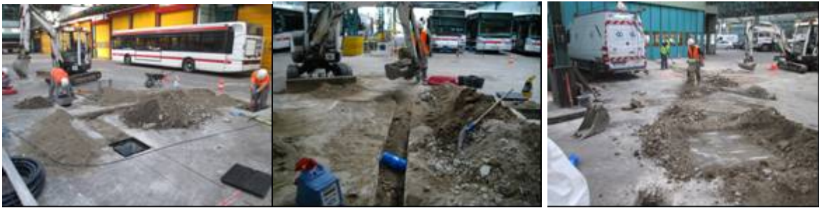
Figure 9 : Terrassement et remblaiement des tranchées
